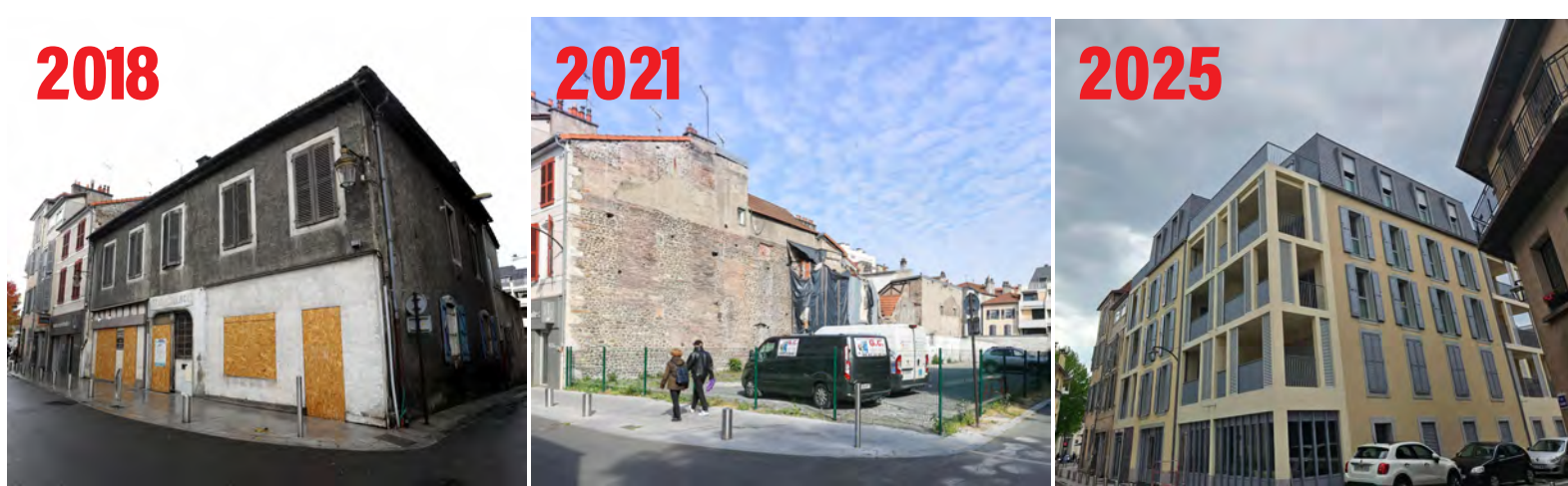
Un exemple de ce que veut encourager l'agglomération de Pau-Pyrénées, la régénération d'îlots, comme ici rue Louis Barthou à Pau. Un site vétuste qui a après son acquisition a été démoli pour permettre la construction, par la Sepa, d'une résidence qui offrira 26 nouveaux logements. Archives PP et E.N
