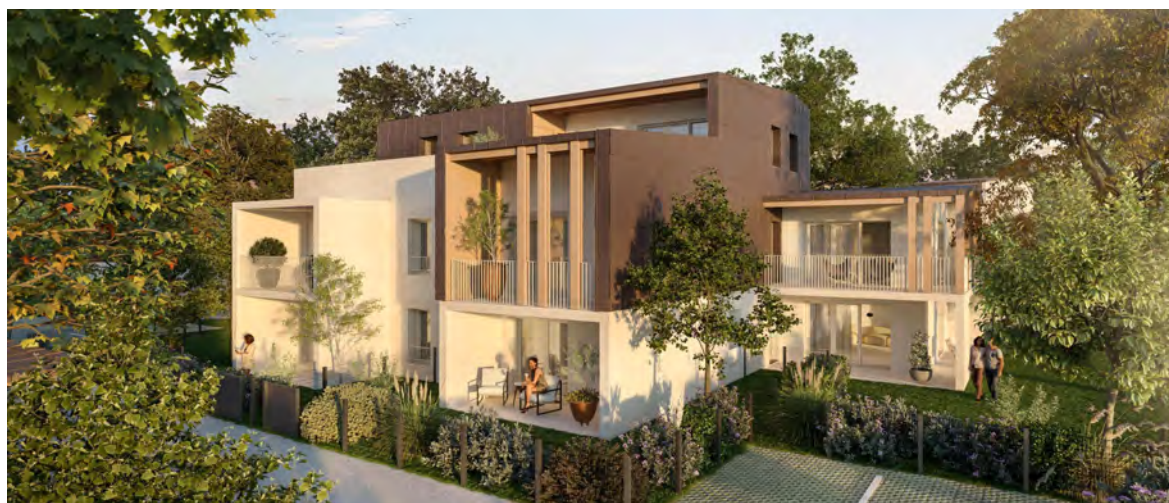
Les logements du Domaine Hazelia à Idron dont le chantier doit débuter en septembre. Axias Habitat
