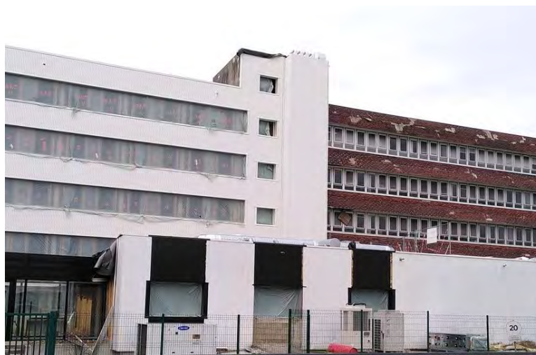
La réhabilitation de l'ENSGTI, à Pau, est un projet représentatif de la dynamique actuelle : solarisation, éolien en toiture, isolation par l'extérieur... Orpi Pro
